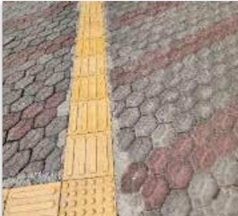
Braille Blocks (Jalur Pejalan Kaki Tunanetra)
