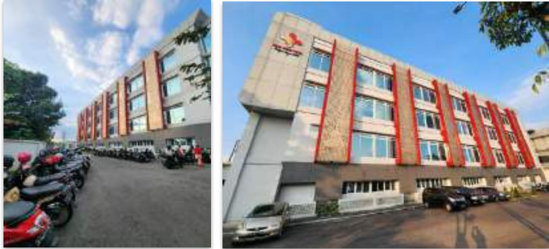
Gambar IV. 1 Dokumentasi Area Parkir RSUD Merah Putih Kabupaten Magelang
